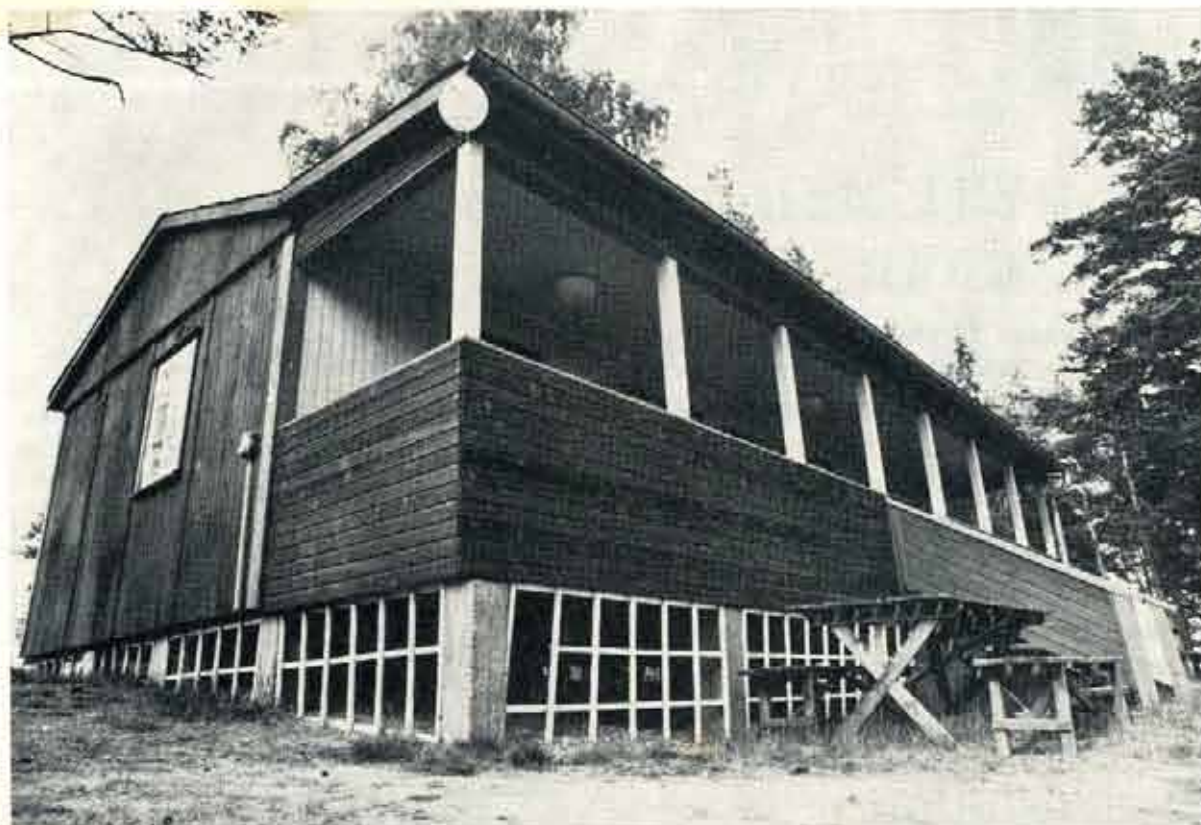
Paviljongen, som alla Sunlightare har tillträde till, har utrustats med elektricitet och telefon och mysats till i det stora rummet. Trickfoto.
