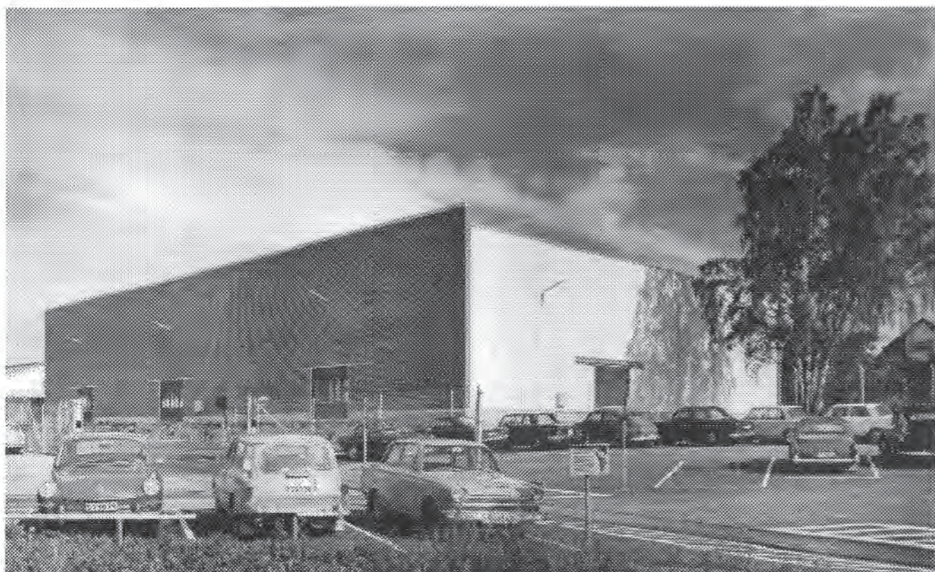
Den nya lagerbyggnaden 36 stod färdig 1968. Det enda som finns kvar av Hagby och Merensborg är björken till höger.
