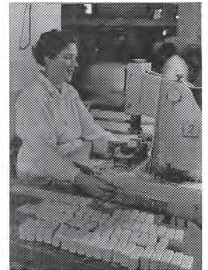
Trots satsningar på automatisering fanns det fortfarande mycket att förbättra på 50-talet. Här en halvautomatisk tvålstansmaskin.
