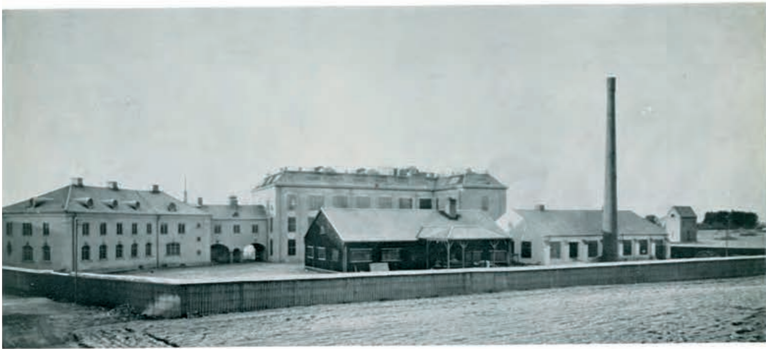
Totalvy av fabriken i Nyköping år 1925. De två låga byggnaderna är verkstaden och panncentralen.
